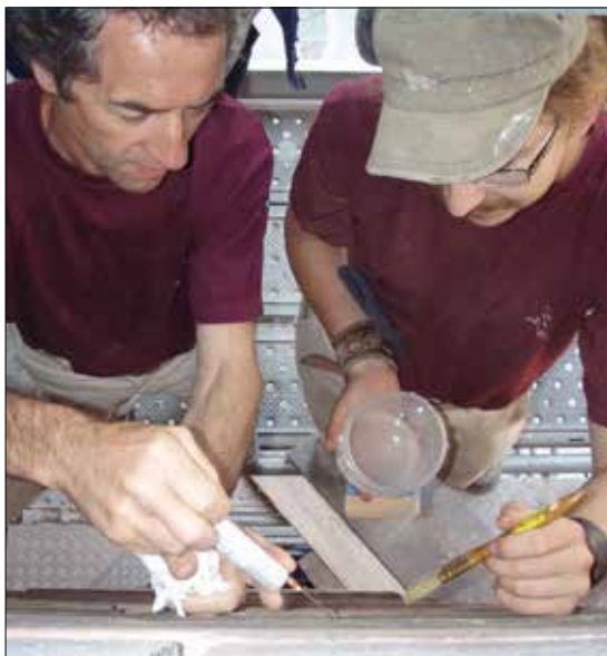
Pré-mouillage et injection sur le chantier du mur ouest du transept sud
