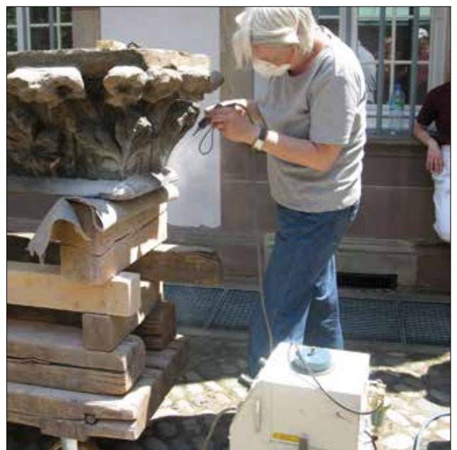
Nettoyage des croûtes noires sur un élément de corniche
