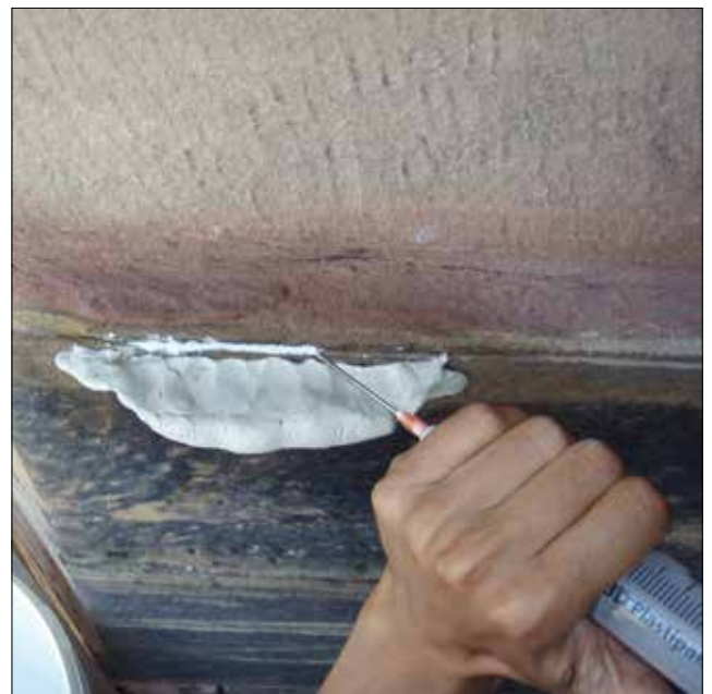
Cuvette de protection en terre glaise lors de l'injection du PLM-M
