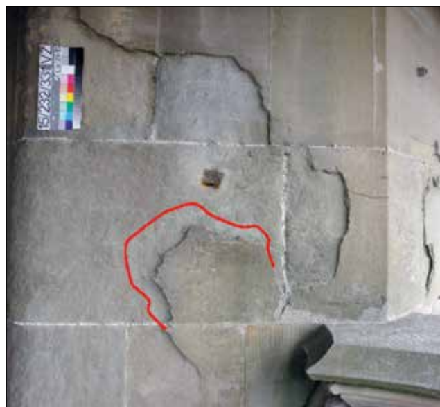
Figure 1 : La cartographie montre la quantité de plaques sur la façade échafaudée. (Cartographie - extrait : M. Baud, Cœuvre Notre-Dame , fév. 2009)
