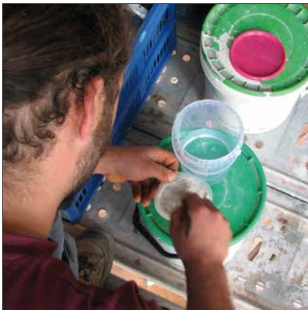
Préparation du mortier d'injection PLM-M
