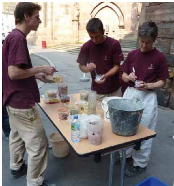
Les artisans de la Fondation procèdent à la préparation du mortier
