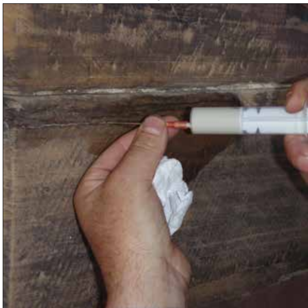
Mise en œuvre du gel de silice
