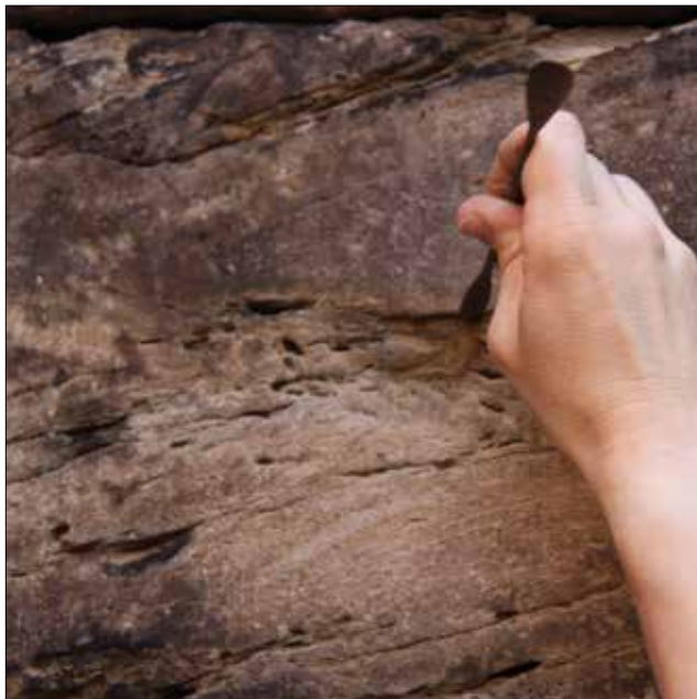
Application du mortier à la spatule
