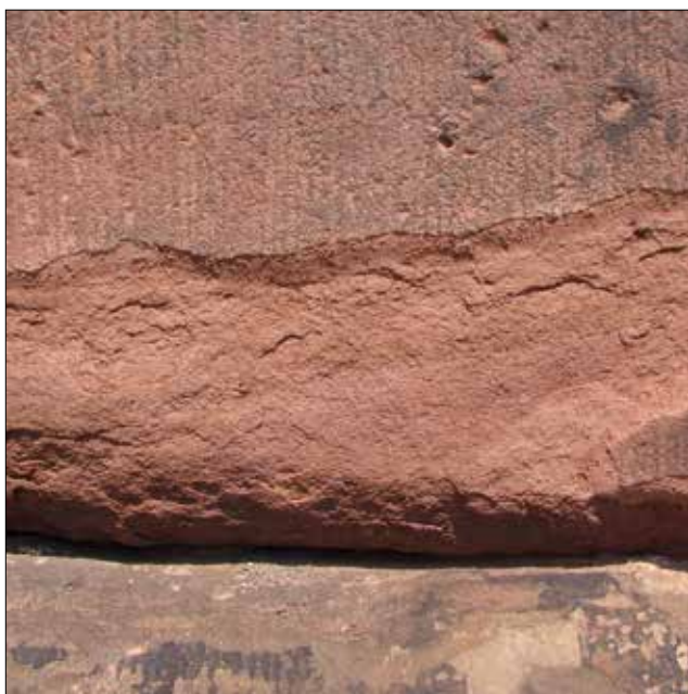
Solin terminé dans les tons rose
