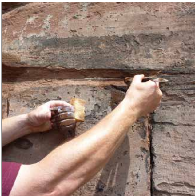
Façonnage du mortier sur support mouillé
