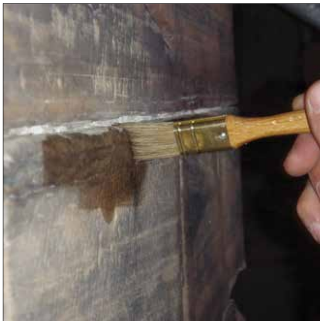
Comblement par injection de gel de silice à charge siliceuse, préparation du support par mouillage à l'alcool
