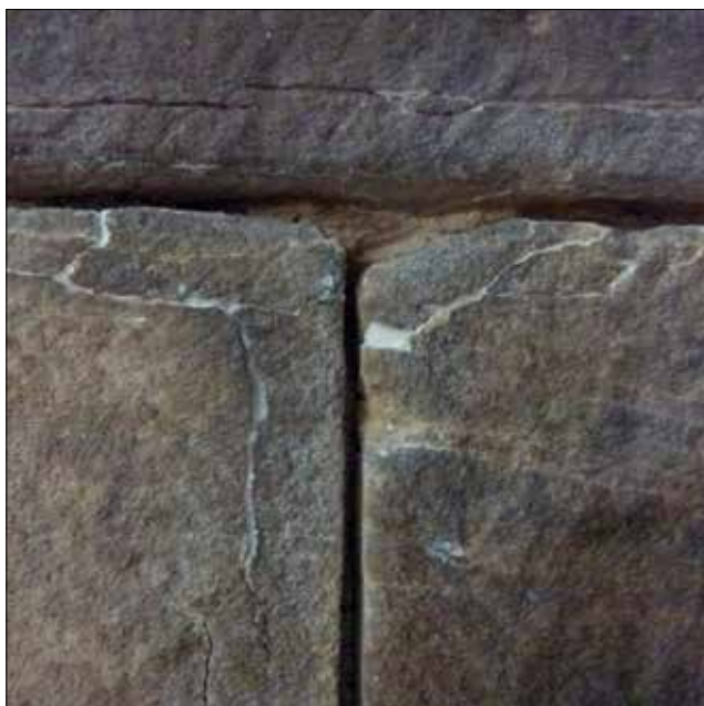
Application du gel de silice terminée
