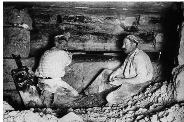
Souchevage dans une carrière à Bbagneux.(Archive IGC)
