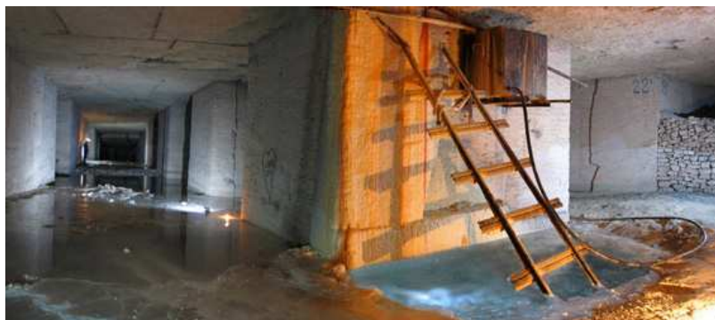
Carrière exploitée par pilier tournés carrés (Carrière de Merry-sur-Oise)
